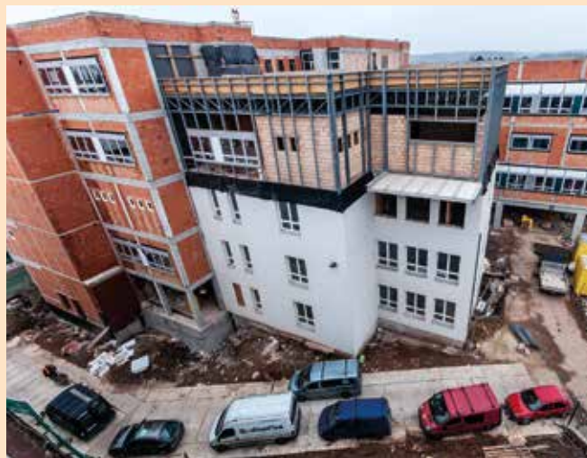
Stavba Perinatologického centra
